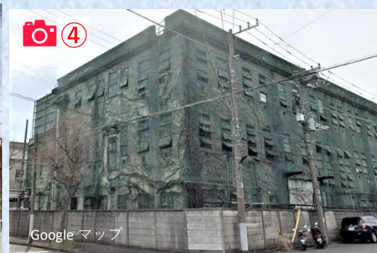
風洞試験関連 建屋 [現 東邦化学工業]
