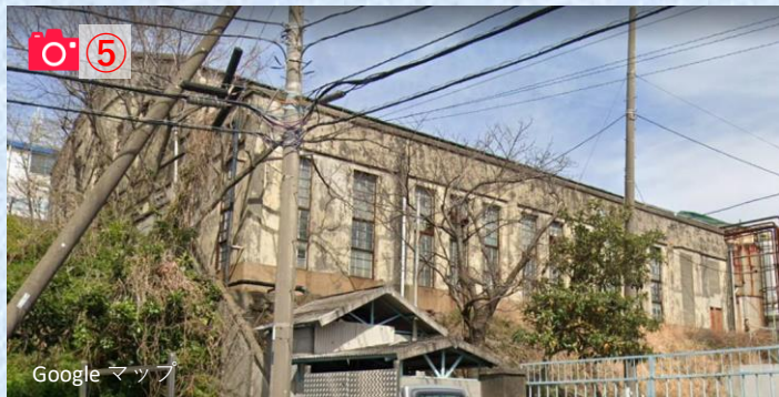
風洞準備室 建屋 [現 東邦化学工業]
