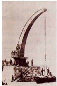
旋回固定埠頭クレーン
