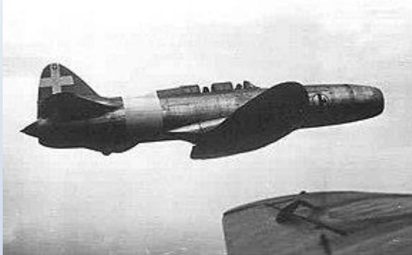
1940年イタリアのカンピーニの発明された「プロペラを使わない航空機カプロニ・カンピニ N.1(実験機)
