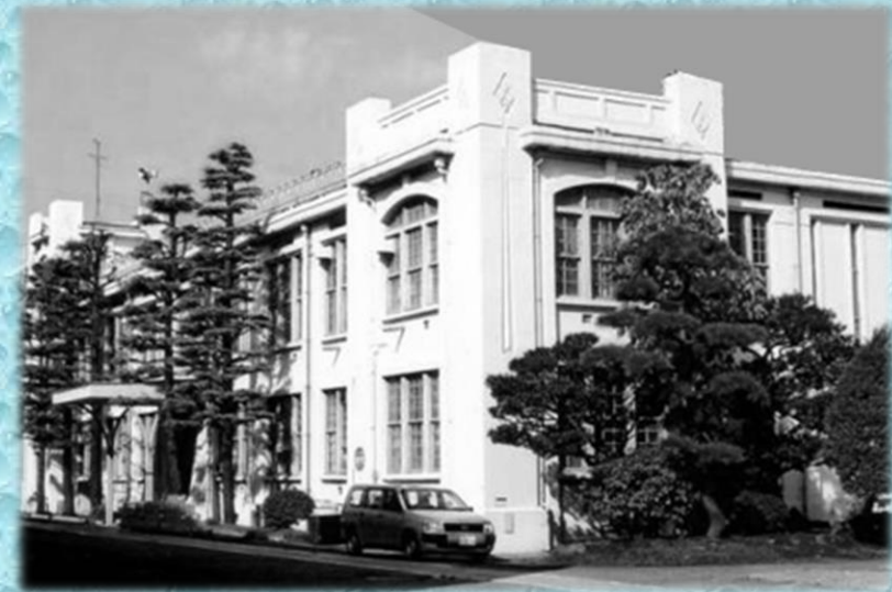
海軍工廠造兵部本館 (現東芝ライテック横須賀工場管理棟)
