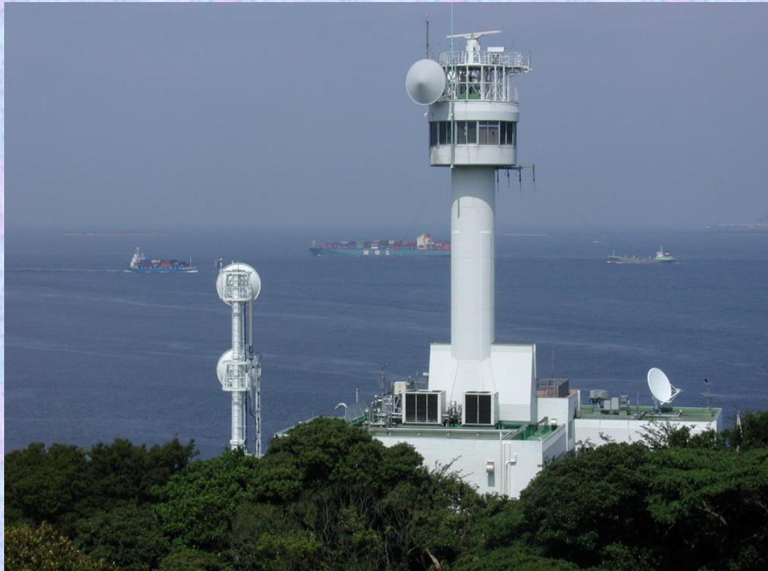
横須賀市観音崎の東京湾海上交通センター (後方は東京湾浦賀水道)
