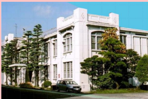
海軍工廠造兵部本館 (現東芝ライテック横須賀工場管理棟)
