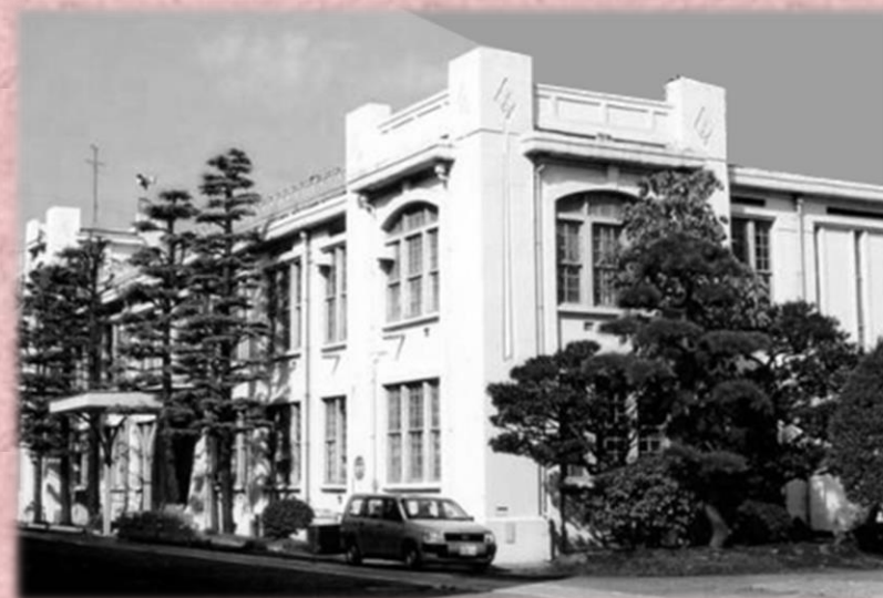
海軍工廠造兵部本館 (現東芝ライテック横須賀工場管理棟)
